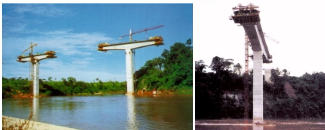
FIGURA 1.4 - Ponte sobre o Rio Maranhão ( cortesia Construtora Camargo Corrêa ).
