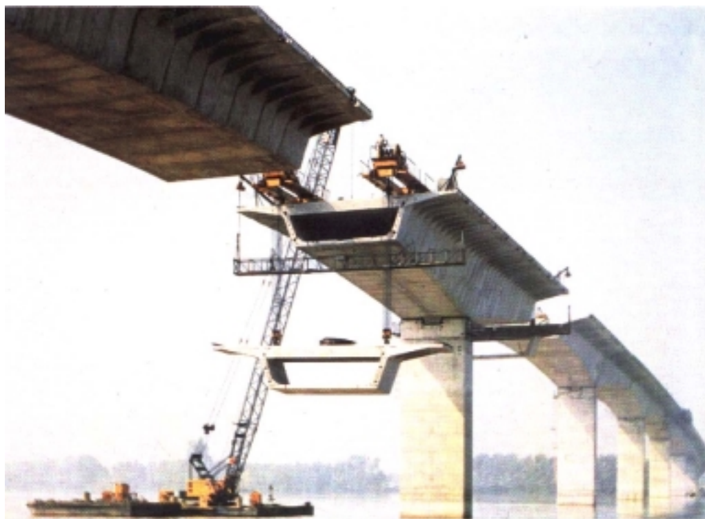
FIGURA 1.3 - Ponte protendida em balanços sucessivos - (cortesia J. Muller International, Inc.).
