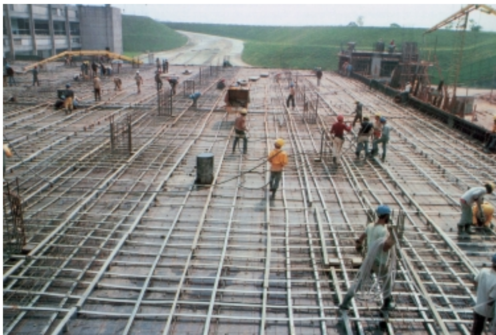
FIGURA 1.19 - Edifício com laje cogumelo protendida.
