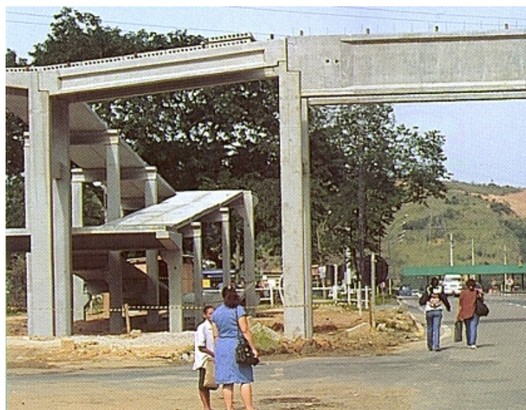
FIGURA 1.16 - Passarela de pedestres em vigas pré-moldadas protendidas ( Cortesia CONCRE )
