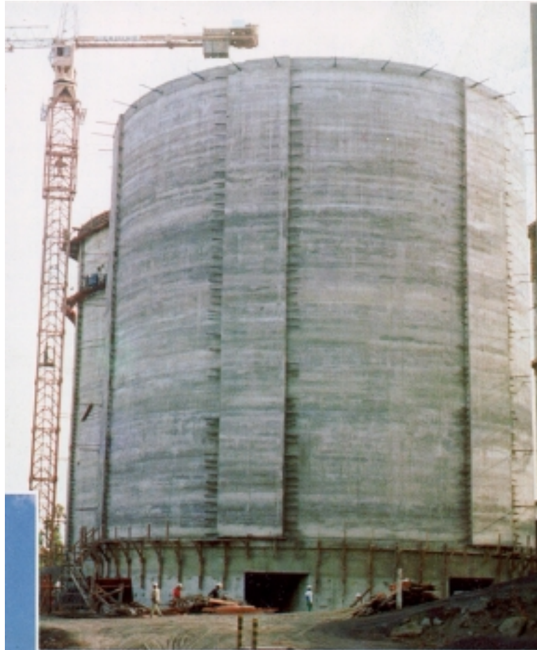
FIGURA 1.21 - Silo em concreto protendido
