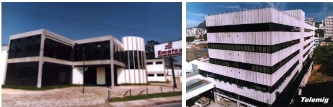
FIGURA 1.14 - Aspecto de construções em pré-moldados - edifícios (Cortesia PRECOM)
