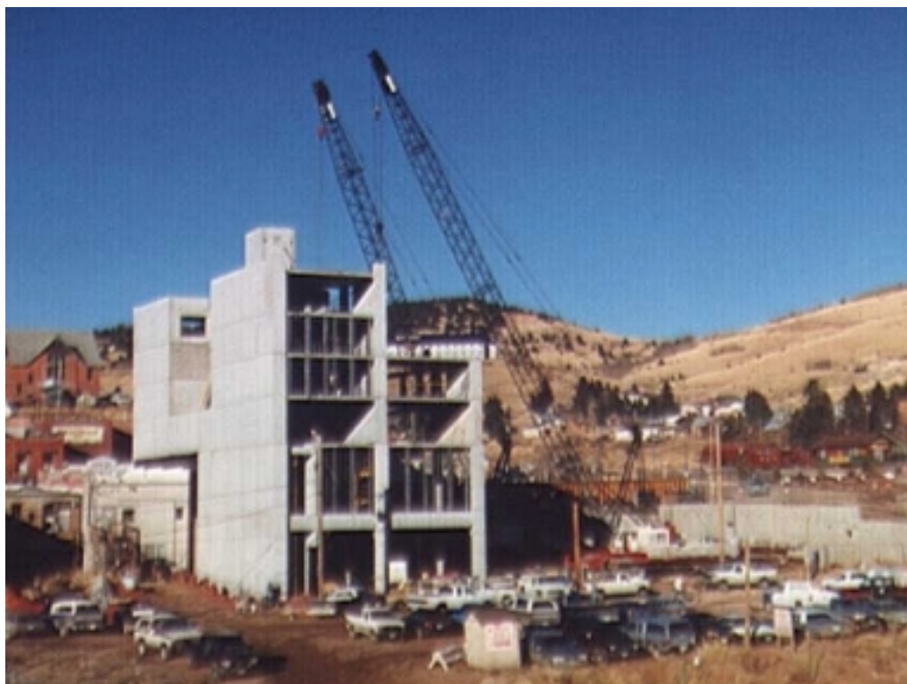
FIGURA 1.17 - Edifício em pré-moldados protendidos (USA)
