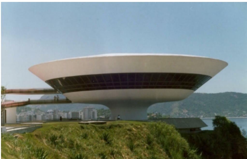
FIGURA 1.22 - Museu Nacional de Arte Contemporânea - Estrutura de concreto protendido (Projeto de Oscar Niemeyer - Niterói/RJ)
