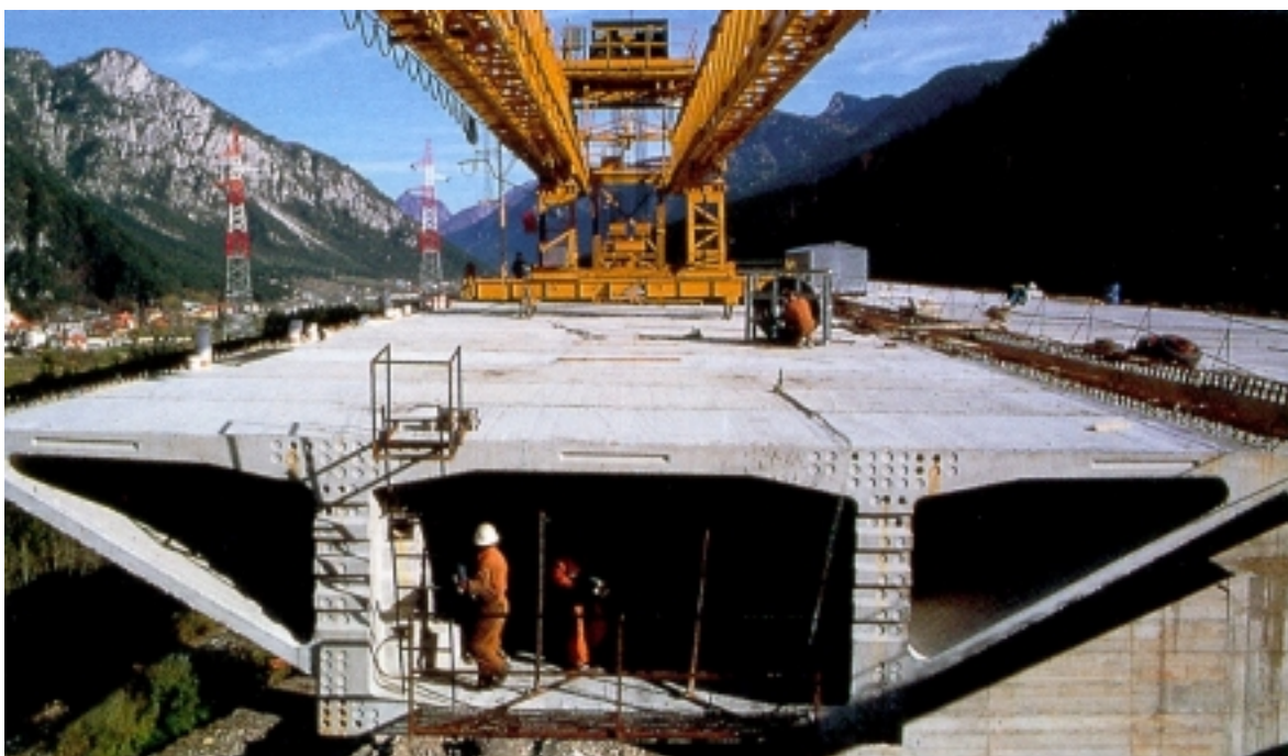
FIGURA 1.7 - Ponte protendida em balanços sucessivos - (cortesia FIP Industriale - Itália).
