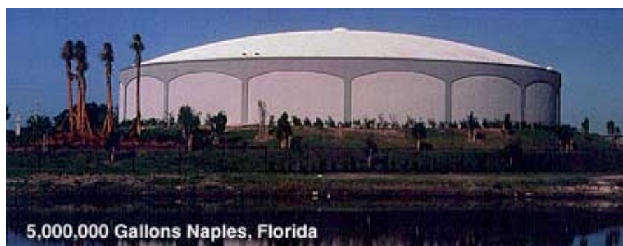
FIGURA 1.20 - Reservatório de água em concreto protendido (Flórida - USA)
